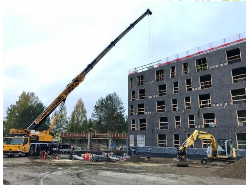
Kuva Opiskelijankadun rakennustyömaasta
