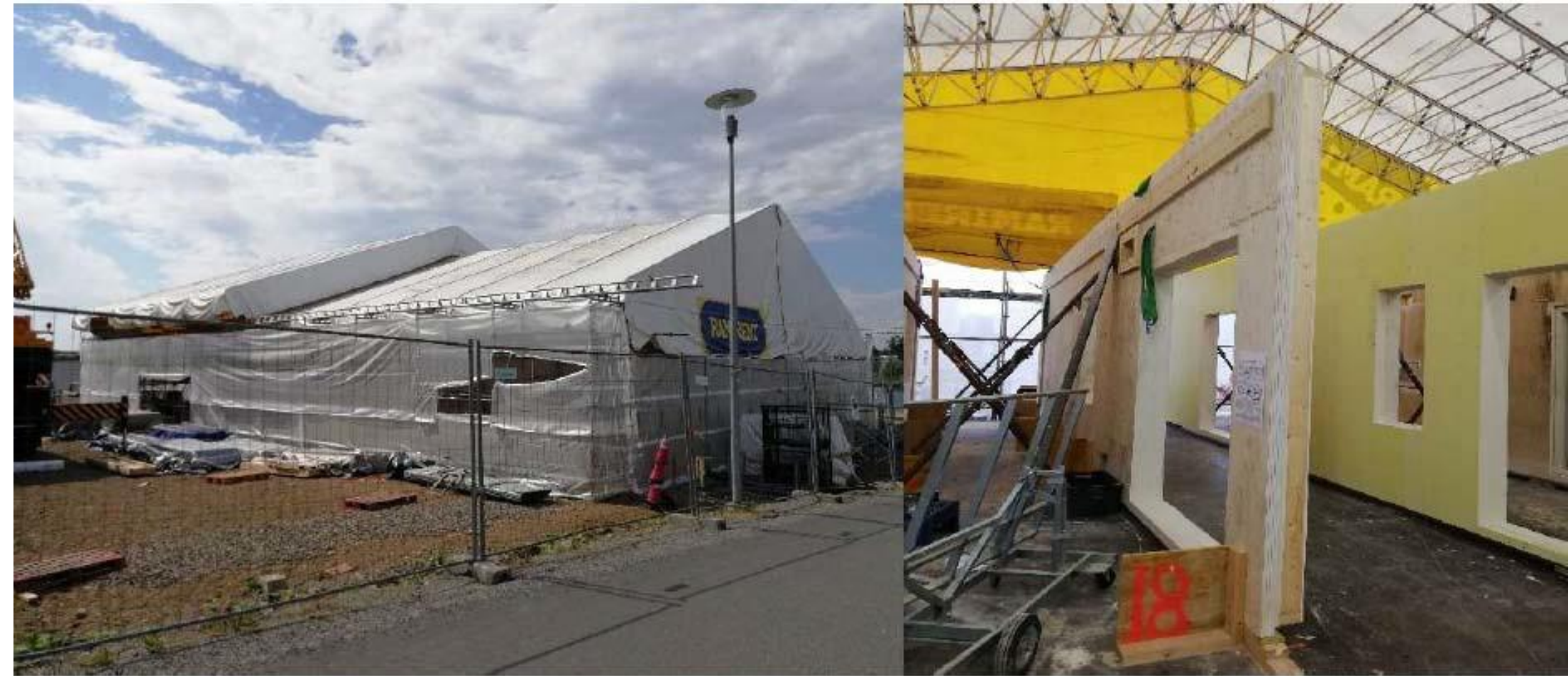
Ulkoseinäelementit kasataan sääsuojateltassa valmiiksi nostoa varten
