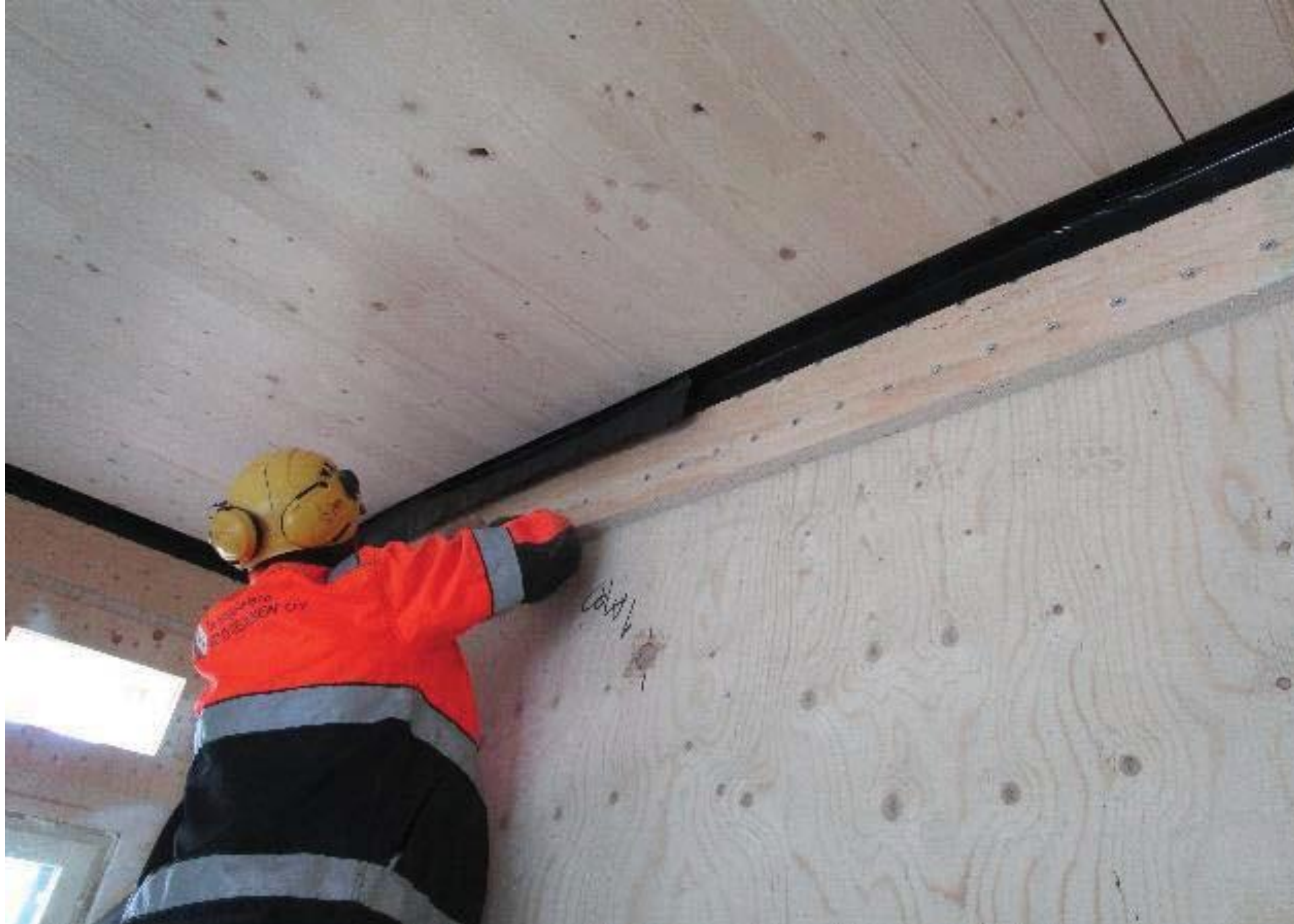
Elementtien saumojen teippausta. Saumat teipataan ennen kulmarautojen asennusta. (Kuva: TTS – Työtehoseura)
