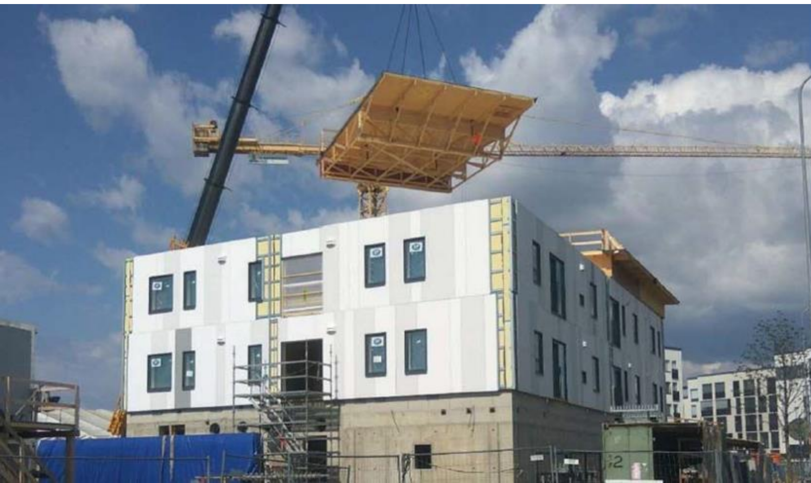
Kattolohkon nostaminen paikoilleen
