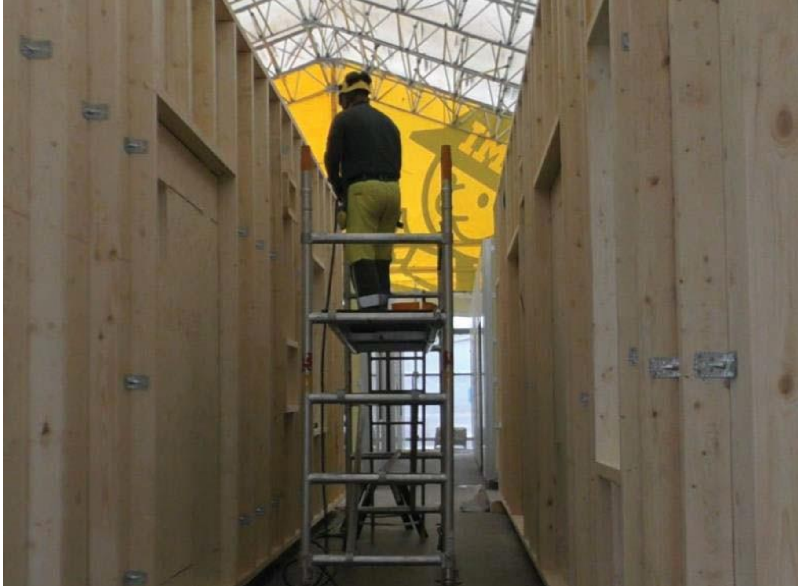
Varustelutyötä siirreltävän työtelineen päältä. Käynnissä rankojen asennus. (Kuva: TTS – Työtehoseura)
