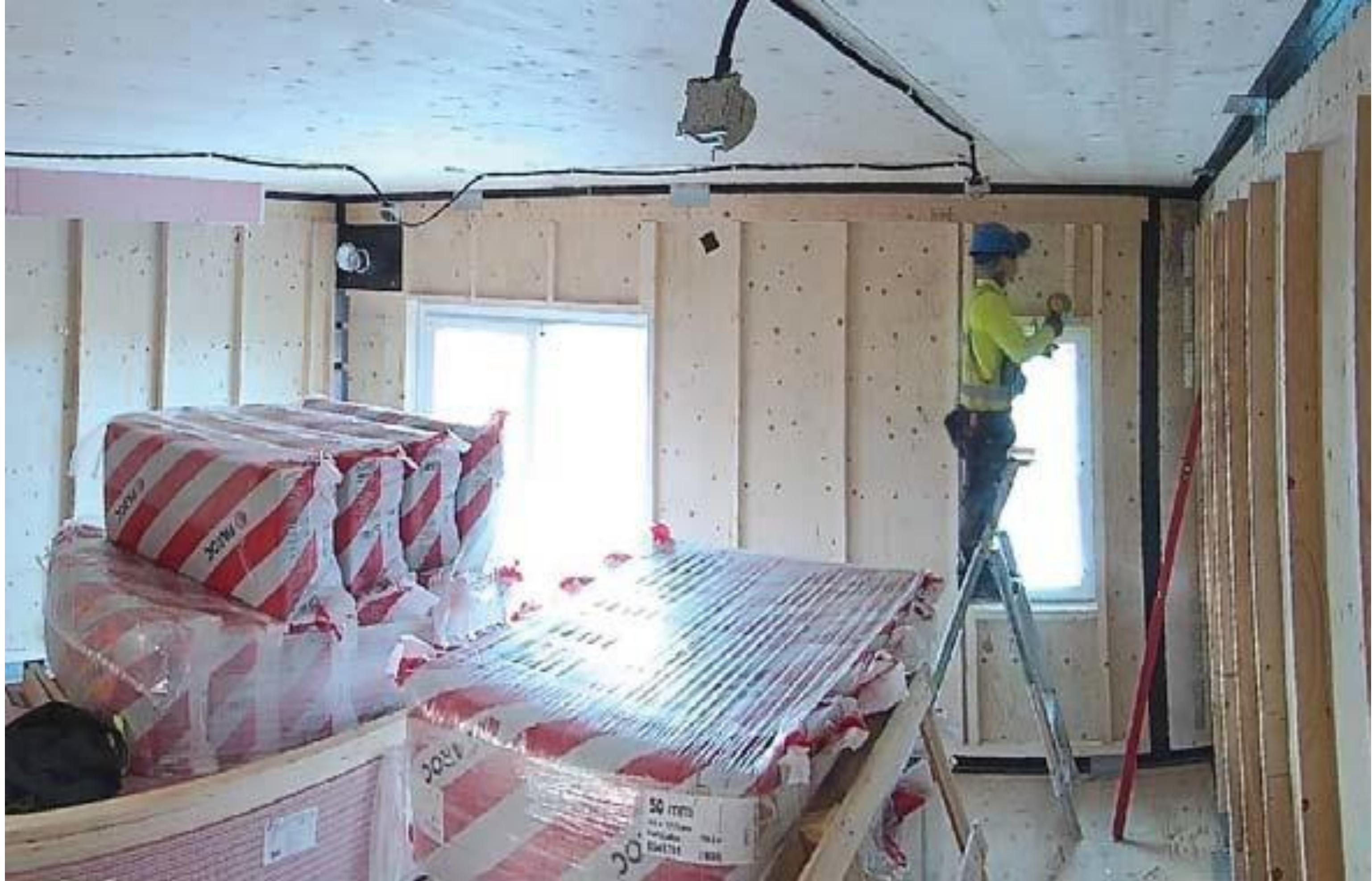
Rankojen asennus lisäeristystä varten. (Kuva: TTS – Työteho-seura)
