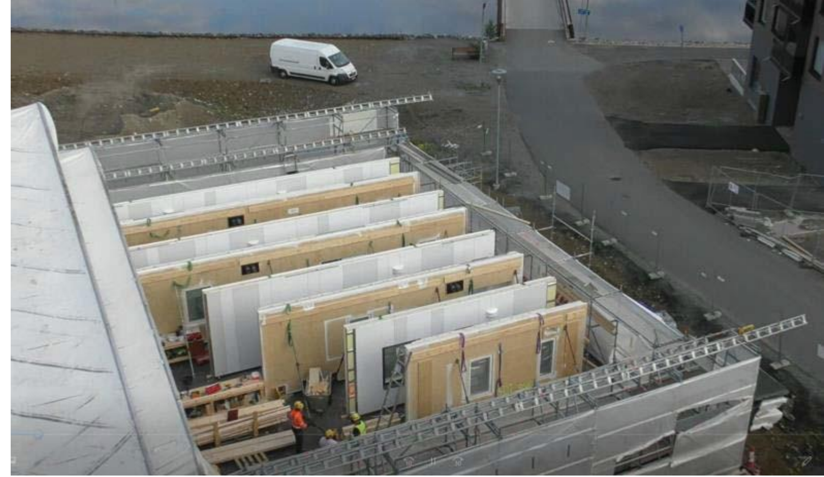
Sääsuojan katto siirretty sivuun, nostotyö alkamassa. Kuvassa näkyvillä kaikki viidennen kerroksen ulkoseinäelementit. Taustalla näkyvä Pielisjoki virtaa Pyhäselkä-järveen. Järven läheisyydestä johtuen rakennuspaikka on usein tuulinen. (Kuva: TTS – Työtehoseura)
