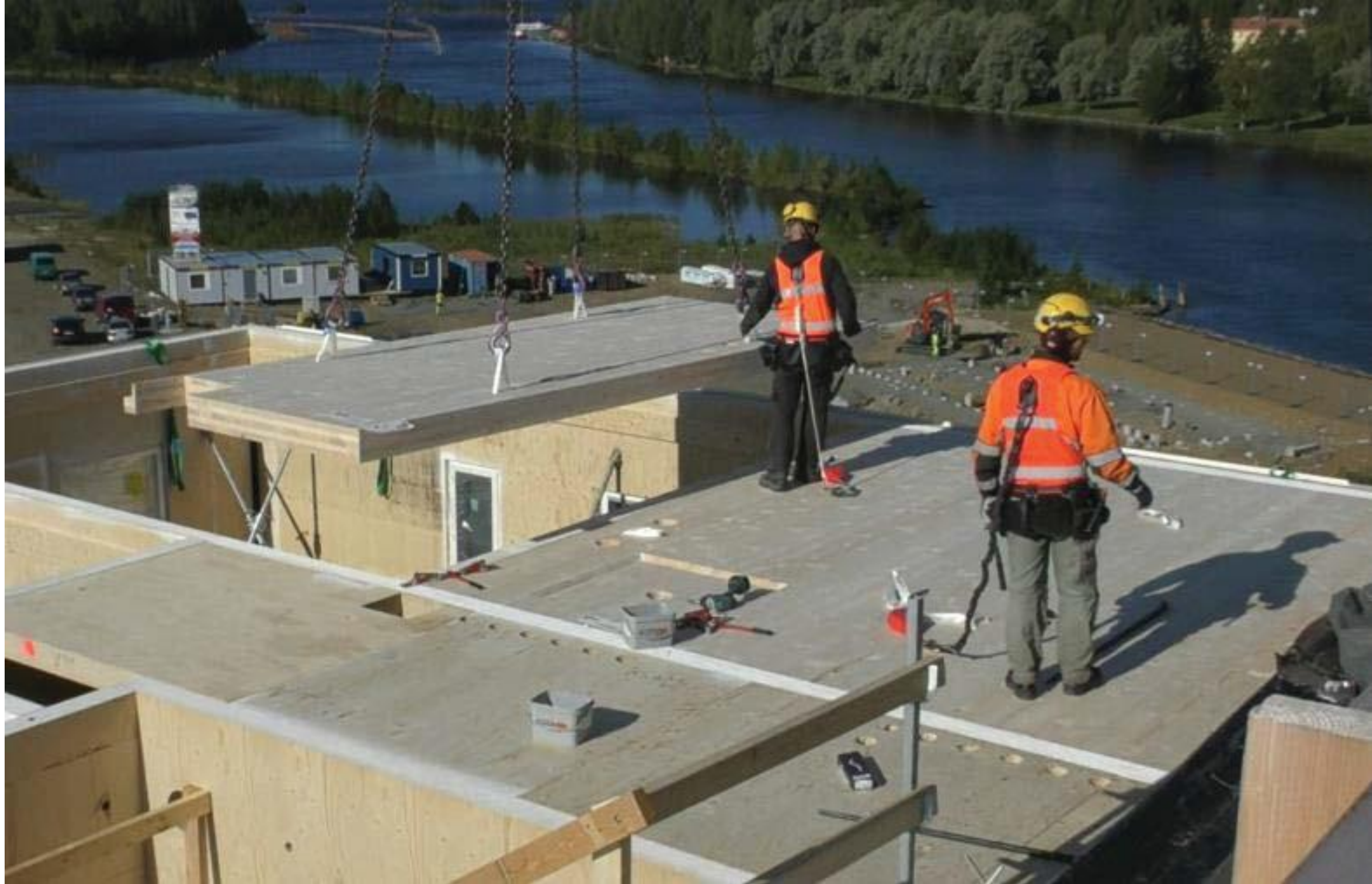
CLT-välipohjaelementin asennus. Nostolenkkeinä toimivat liinat asennettu valmiiksi tehtaalla. (Kuva: TTS - Työtehoseura)
