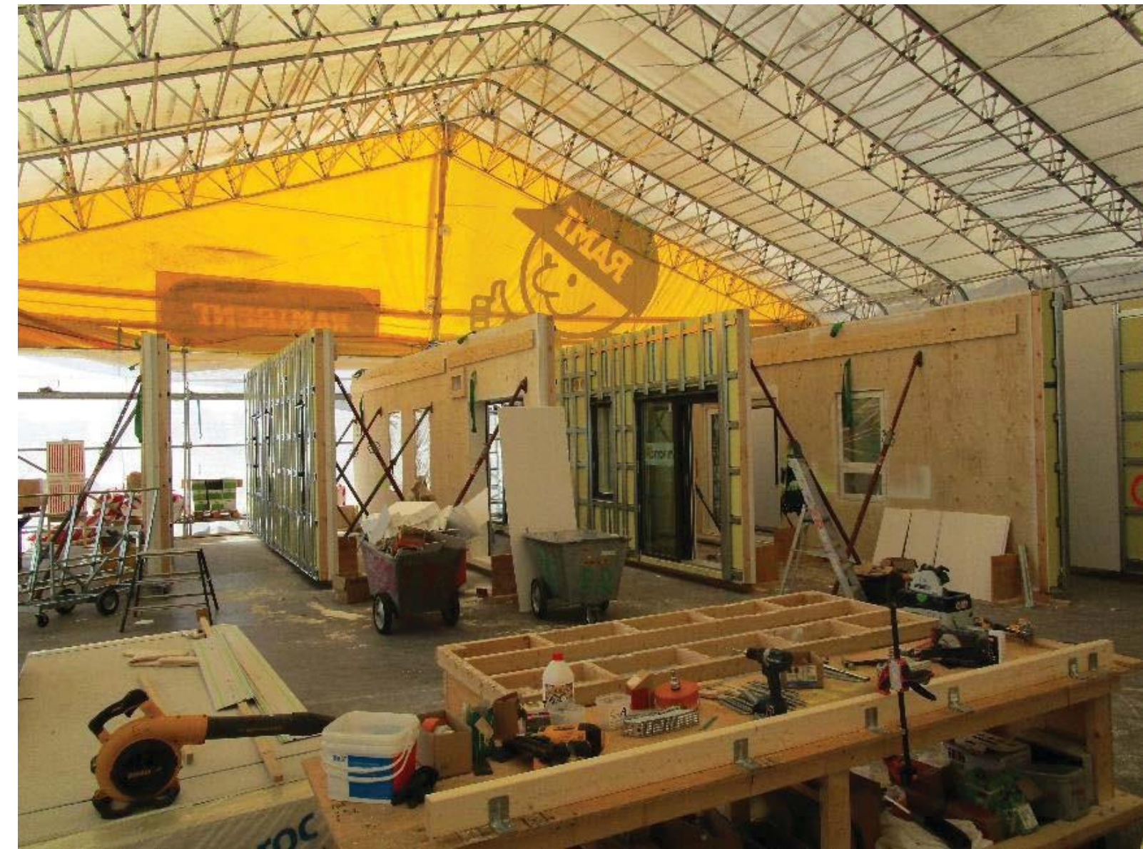
Ulkoseinäelementit kasataan sääsuojateltassa valmiiksi nostoa varten
