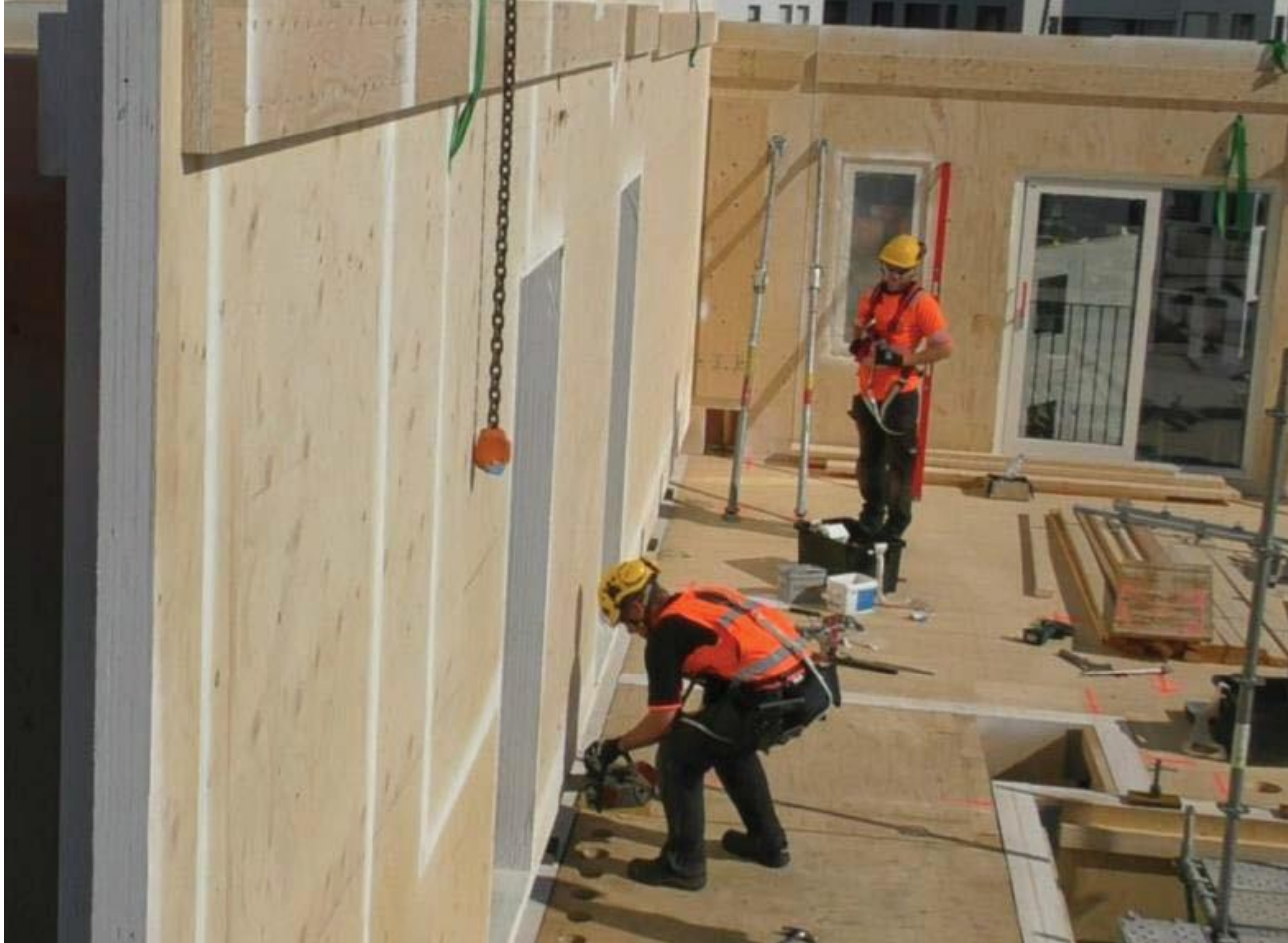
VS-elementistä puuttuu työstö alhaalta tulevan jännetangon kohdalta. Asentaja avaa tarvittavan varauksen ketjusahalla. (Kuva: TTS – Työtehoseura)
