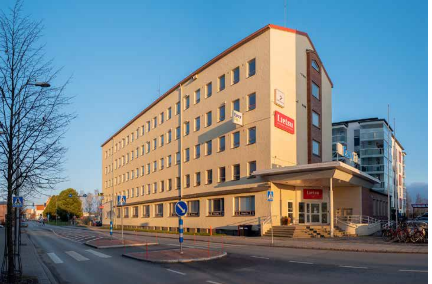
Joensuuhun vuonna 1955 valmistunut virasto- ja postitalo. Rakennuksen suunnitteli arkkitehti Annikki Virtanen. Kuva Jani Penttinen.
