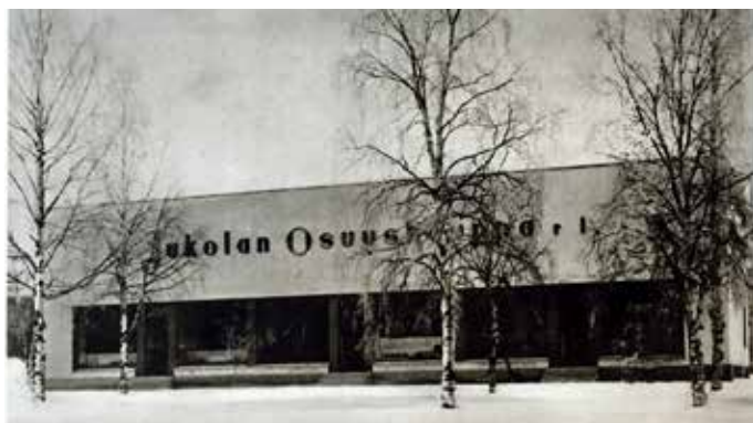
Vuonna 1934 valmistunut Jukolan Osuuskaupan kauppalan myymälä alkuperäisessä asussa Kirkko- ja Torikadun kulmauksessa Nurmeksessä. Ajoittamaton kuva. Kuva postikortti.
