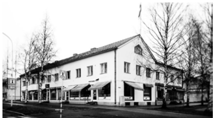
Entinen Jukolan Osuuskaupan kauppalan myymälä kuvattuna vuonna 2016.
