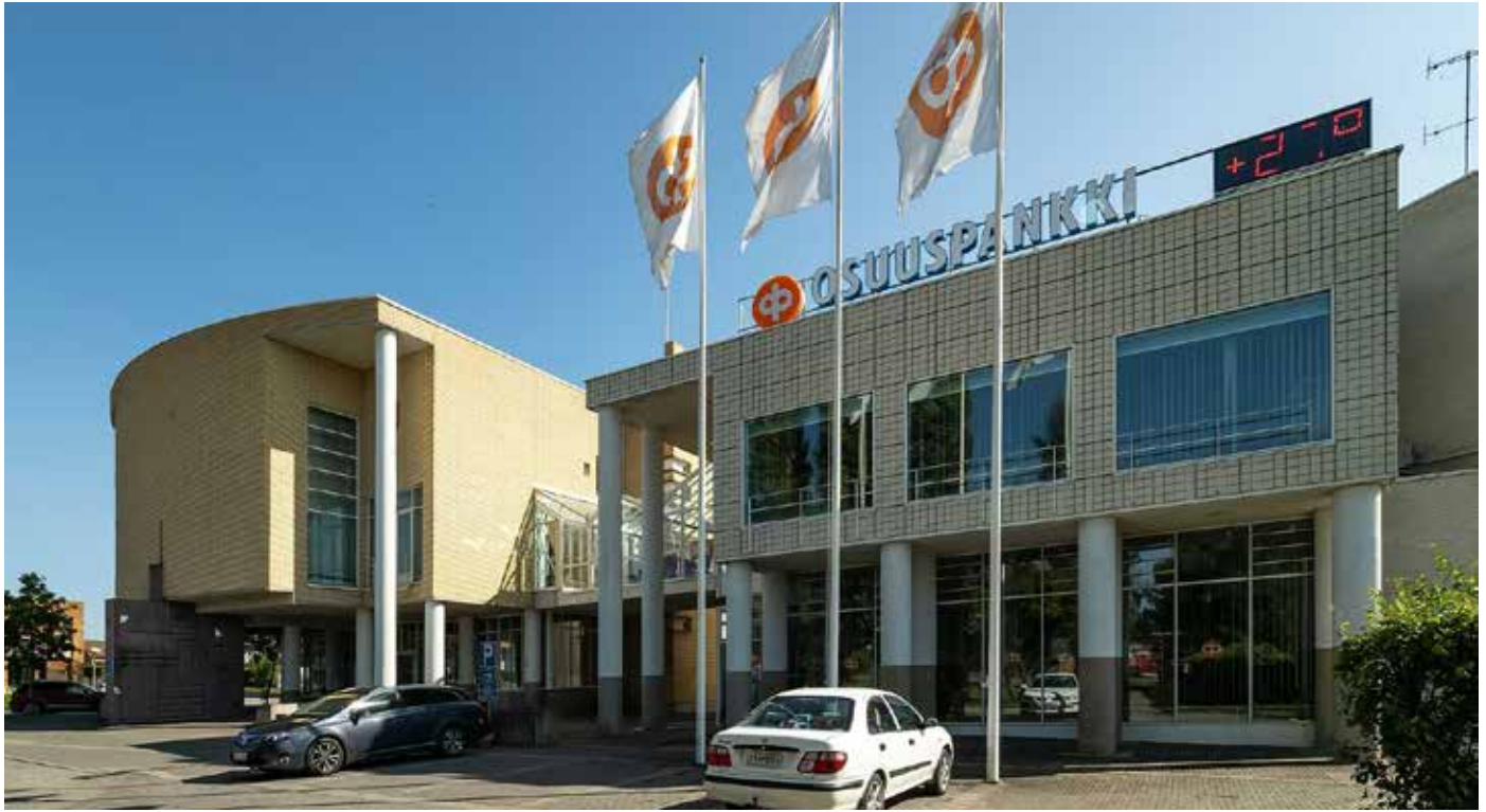
Rääkkylän kunnantalon pääjulkisivua rytmittävät useat massiiviset pylväät.
