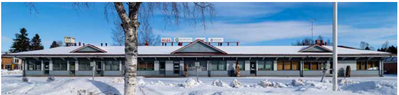
Ilomantsin entinen linja-autoasema Kalevalantien varrella. Rakennuksen on suunnitellut arkkitehtitoimisto V. Suonmaa ja V. Rotko. Se valmistui vuonna 1966.
