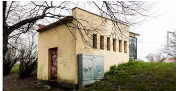
Sähkömuuntoasema Aittarannan pohjoisosassa, Itäranta 14:ssä.
