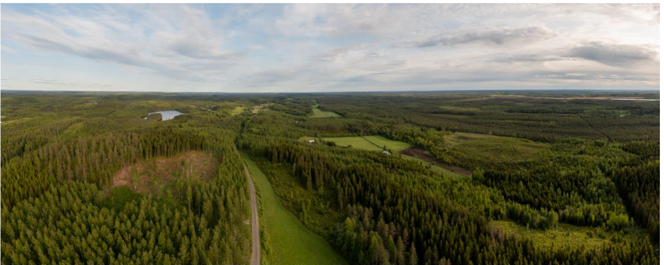
Kuva 36. Pohjoisosa, etelään, 120 m korkeus
