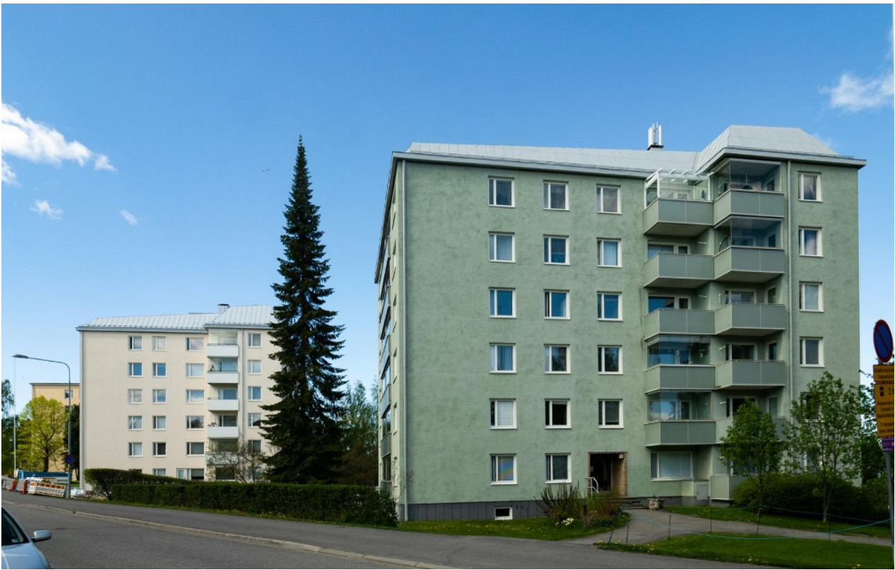
Etummaisena Asunto-Oy Huvilakatu 1 ja sen takana ns. Asunto Oy Tikkamäentorni. Alla: Ns. Rautatieläisten talot, koska alunpitäen ne rakennettiin vuokratiloiksi rautatieläisille.
