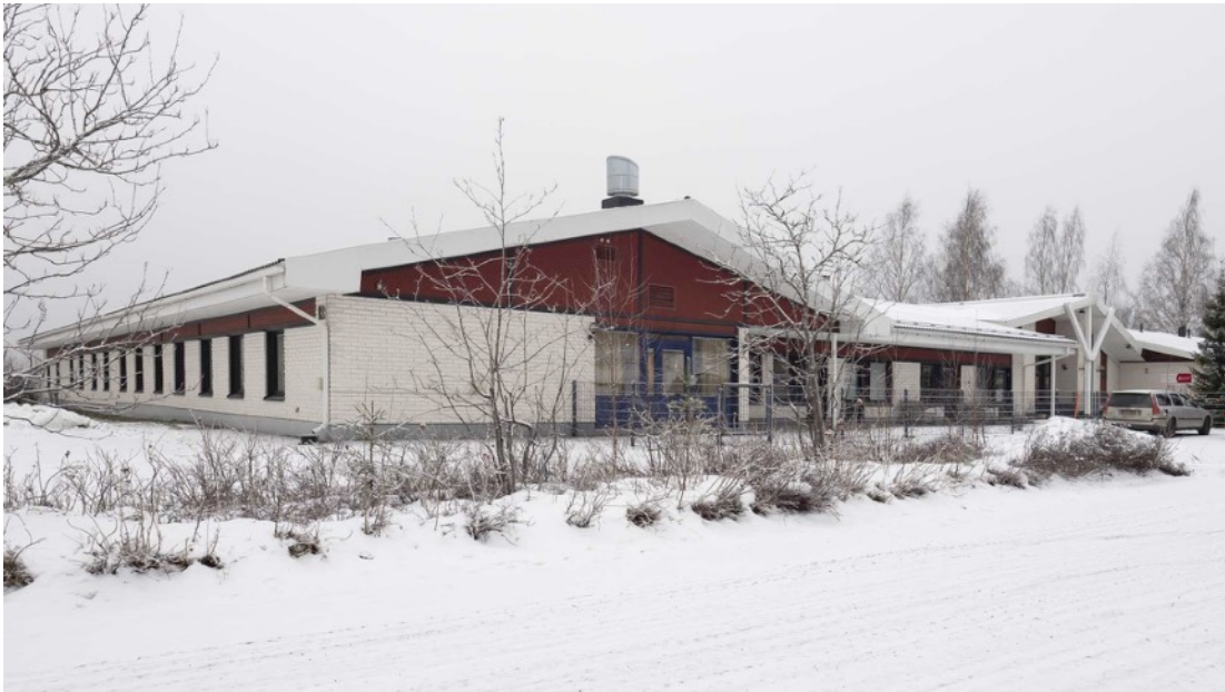
Kunnantalon läheisyydessä sijaitsee vuonna 1986 valmistunut Säästöpankin liiketalo ja ravintola Loitsuvaara on myös Kaj Michaelin suunnittelema. Rakennuksen käyttötarkoitus on muuttunut.
