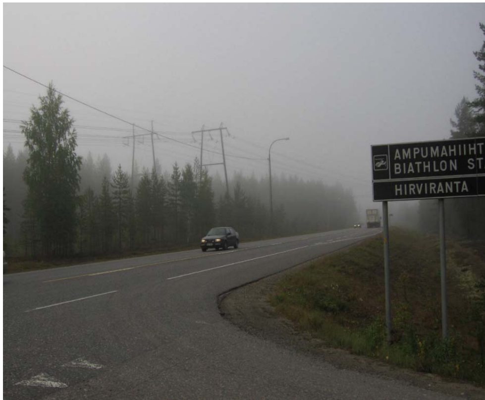
Kuva 10. Kontiolahden Lehmo. Uusi voimajohto sijoittuu kahden nykyisen 110 kV voimajohdon rinnalle. Kuvassa voimajohtojen reitti valtatie 6:n yli menee hyvin viistosti ja sijainti Lehmon asutusalueen ja ampumahiihtostadionin välissä aiheuttaa johtojärjestelyjen tarvetta.
