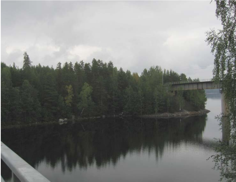
Kuva 3. Syrjäsalmi (VE 1). Maantiesilta vasemmalla alakulmassa ja rautatiesilta oikealla. Siltojen välinen etäisyys on noin 90 metriä ja uusi voimajohto sijoittuisi keskikohdasta oikealle.
