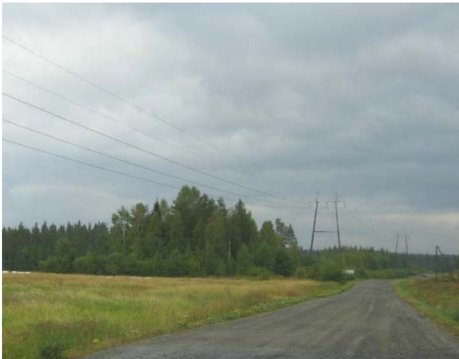
Kuva 8. Kiteen Tolosenmäki. Uuden 400 kV voimajohdon sijoittuminen 110 kV voimajohdon rinnalle voi vaihtua puolelta toiselle asutuksen, muun aluevarauksen tai rakennetun infrastruktuurin läheisyydestä johtuen. Kuvassa uusi johto sijoittuisi nykyisen johdon vasemmalle puolelle.
