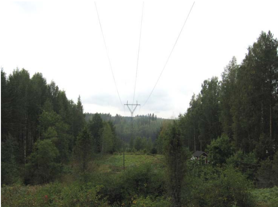
Kuva 4. Pyhäjärven Pölkkyalampi (VE 2) jää kuvan 110 kV pylvään taakse. Kuvassa oikealla lähimmän loma-asutuksen piharakennuksia. 400 kV/110 kV voimajohdon yhteispylväs rakenne on noin 10 metriä kuvan pylvästä korkeampi ja edellyttää johtoaukean leventämistä puolelleen noin 3-6 metrillä (eristinketjurakenteesta riippuen). Yhteispylvään poikkileikkaus on kuvassa 11.
