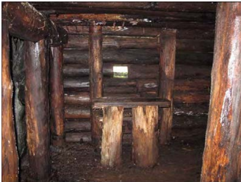
Kuva 124. Hirsinen konekiväärin asekammioliesksan Vornosenvaaran majoitustunnelin alimmassa kerroksessa. Kuva: John Lagerstedt 2011 / Museovirasto DG2583:1.
