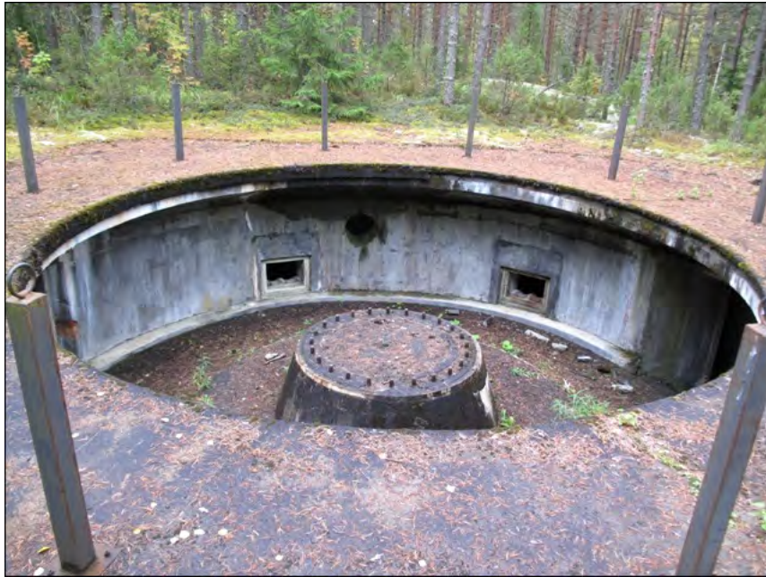
Kuva 27. Tykkiasema nro 306/1 Sulkavan Sarsuinmäellä 152 mm:n Canet-kanuunalle. Oikealla sisäänkäynti tykkiasemaan. Keskellä luukut ammus- ja panossuojiiin. Aseman ympärille on myöhemmin asennettu tolpat suojakaidetta varten. Kuva: John Lagerstedt 2010 / Museovirasto 217984:323.
