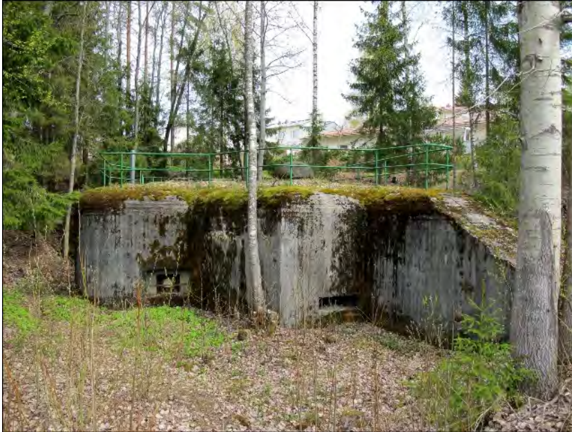
Kuva 17. Panssaritorjuntatykin ja konekiväärin korsu nro 25 Lappeenrannan Skinnarilassa. Vasemmalla tykin ja oikealla konekiväärin ampuma-aukko. Korsun katolle on myöhemmin rakennettu teräskaiteet putoamisen tai katolle kiipeämisen estämiseksi. Kuva: Tiina Mikkonen 2010 / Museovirasto 217984:296.
