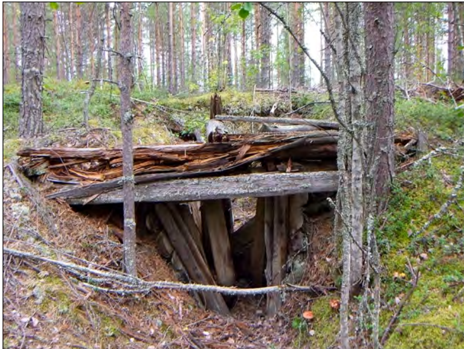
Kuva 8. Kenttälinoitetun majoituskorsun taustalla oleva katto on sortunut mutta sisäänkäynti on vielä hahmotettavissa Kuhmon Saunajärvellä. Kuva: John Lagerstedt 2011 / Museovirasto DG2587:1.
