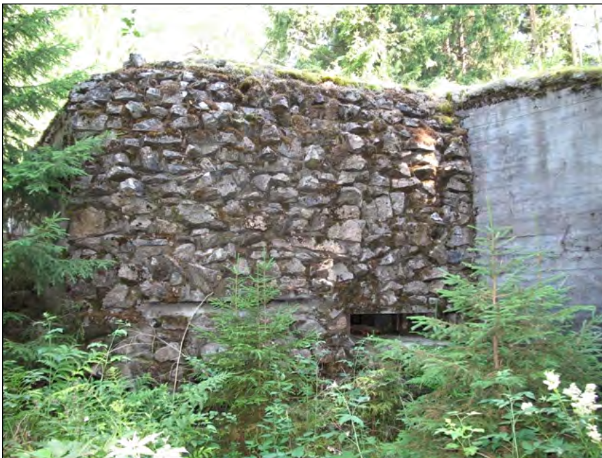
Kuva 13. Virolahden Niemenkankaan konekiväärinkorsiun nro 33 aseseinä on naamioitu kivimuurauksella. Oikealla osa betonisesta siipimuurista, keskellä konekiväärin ampuma-aukko. Vasemmalla, matalien kuusien takana erottuu kapeana rakona asekkammion tähystysaukko. Kuva: Tiina Mikkanen 2010 / Museovirasto 217984:168.
