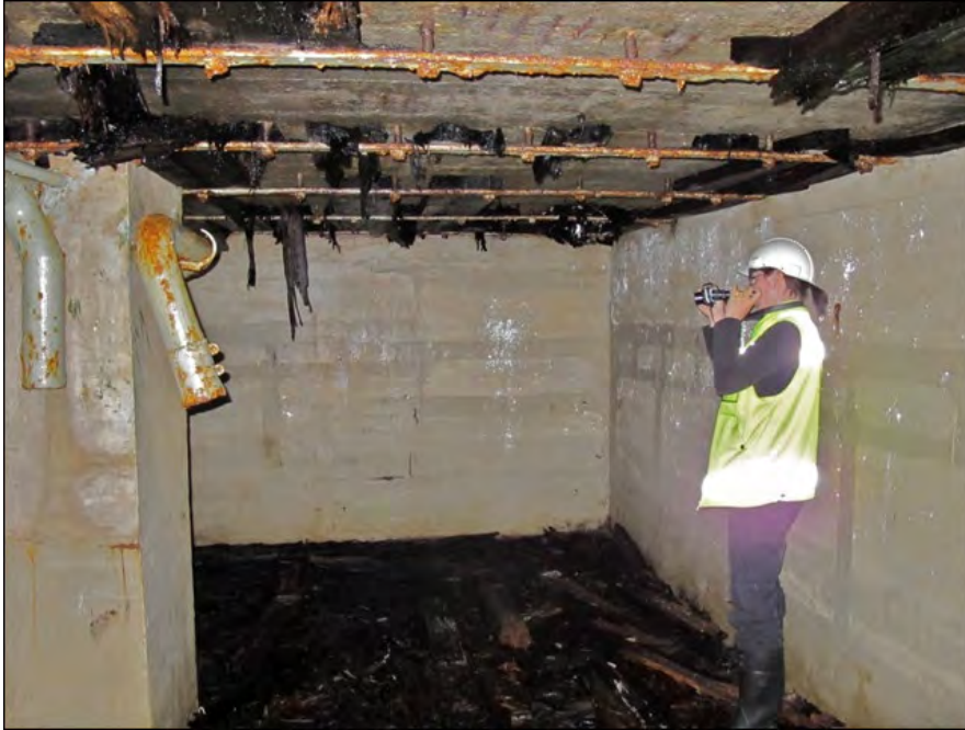
Kuva 4. Tiina Mikkanen dokumentoi Virolahden Kannanmäen korsun nro 158 lahonnutta puista sisäkattoa. Kuva: John Lagerstedt 2010 / Museovirasto 217984:100.
