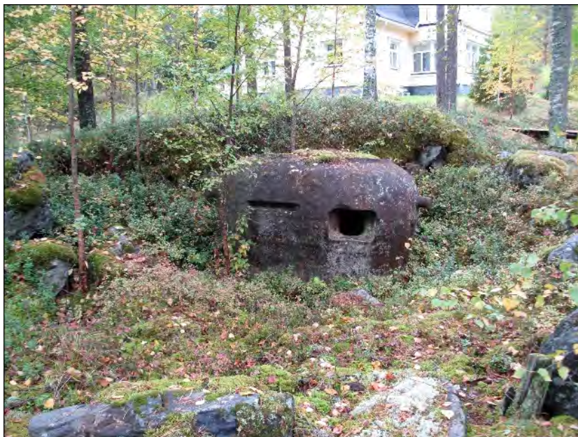
Kuva 20. Konekivääririkupupesäkkeen teräksinen, keskiraskas, vuoden 1943 mallinen kupu on jäänyt peittämättä maakerroksella Kontiolahden Hietalahdessa. Kuva: Markus Kankkunen 2010 / Museovirasto 217984:362.
