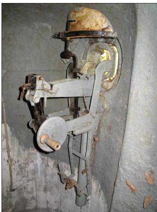
Kuva 15. Konekiväärin jalusta teräksisessä konekivääräkuvussa Luumäen Käpylässä konekivääräkupu-pesäkkeessä C399. Kuva: Tiina Mikkanen 2010 / Museovirasto 217984:241.
