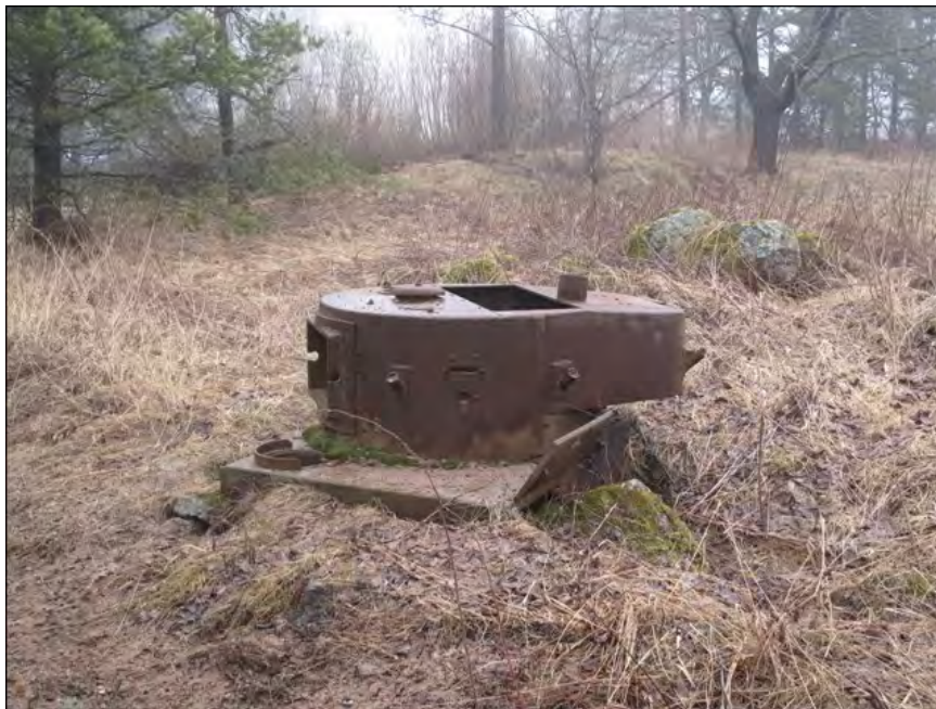
Kuva 26. Neuvostoliittolaisesta T-26 sotasaalispanssarivaunusta rakennettu teräspesäke nro 1 Virolahden Kalliolassa. Kuva: Tiina Mikkänen 2010 / Museovirasto 217984:17.
