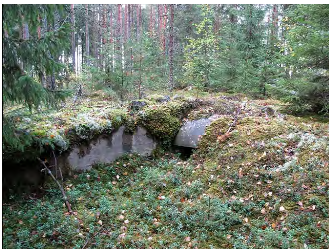
Kuva 14. Korsiin nro 169 teräksisen konekivääräkuvun ampuma-aukko ja ampumasektoria suojaava betoninen siipimuurin Virolahden Ravijoenlahdella. Kuva: John Lagerstedt 2010 / Museovirasto 217984:12.
