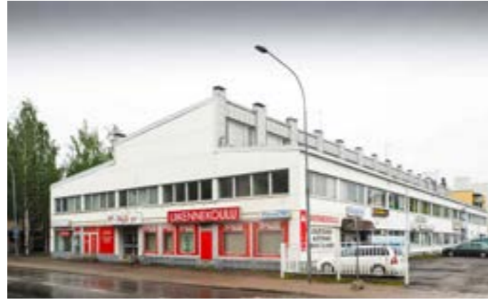
Pienteollisuustalo on purettu vuonna 2017.
