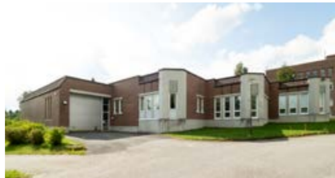
Iiomantsin kunnantalon erillinen kirjastorakennus valmistui 1987.
