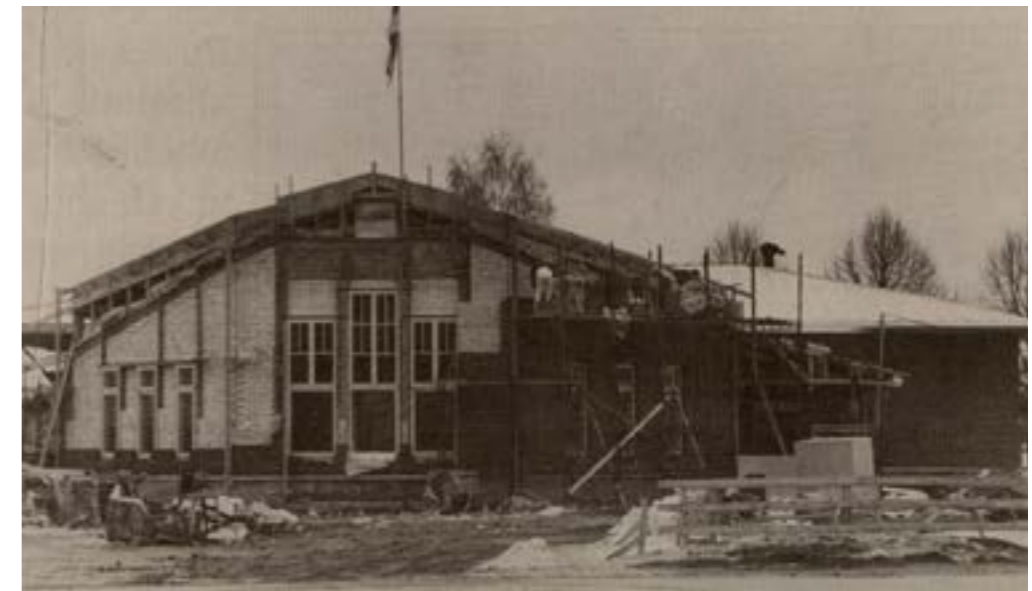
Joensuun linja-autoasema rakenteilla Sirkkalassa vuonna 1985. Kuva Karjalainen 17.4.1985.
