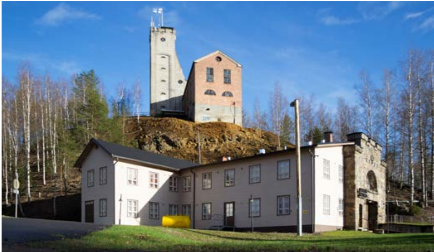
Outokummun kaivostuparakennus on vuodelta 1949, joskin sen linnamaisia mielikuvia korostava kiviportaali on valmistunut vuonna 1927. Taustalla on nostotorni ja sen juuressa sijaitsee murskaamo. Aukeaman kuvat Pekka Piiparinen.
