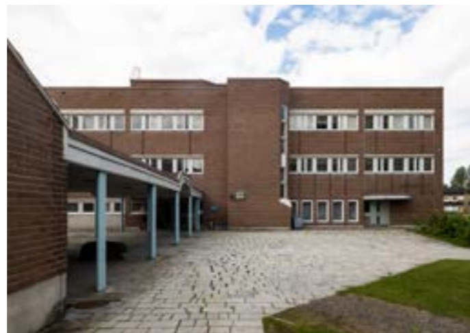
Sammonkadun puolella sijaitsee Valtion virastorakennus.
