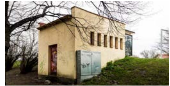
Sähkömuuntoasema Aittarannan pohjoisosassa, Itäranta 14:ssä.
