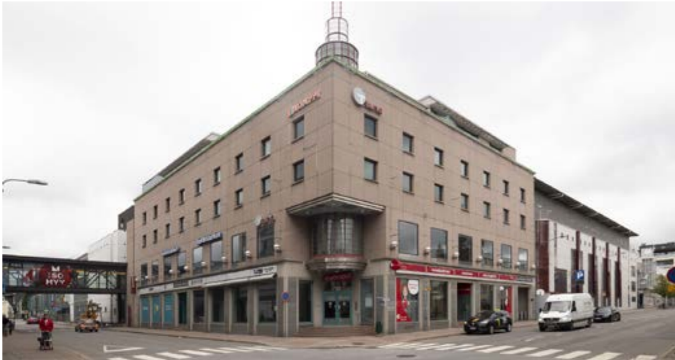
Oy Joensuun Torikatu 29 valmistui vuonna 1992. Kuvassa oikealla näkyy Joensuun toinen pysäköintitalo, joka valmistui vuonna 1987.
